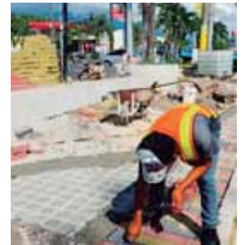
Las cuadrillas colocan adoquines ecológicos.
