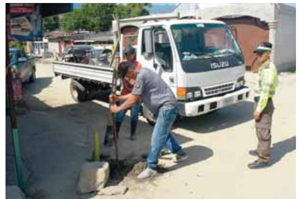
Los trabajos forman parte del proyecto de Suministro e Instalación de Dispositivos de Seguridad Vial y Peatonal.
