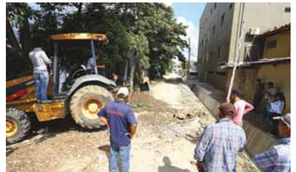
El proyecto inició con las labores preliminares de topografía y excavación.
