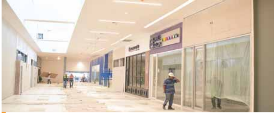
Uno de los pasillos que será habilitado el próximo mes.
