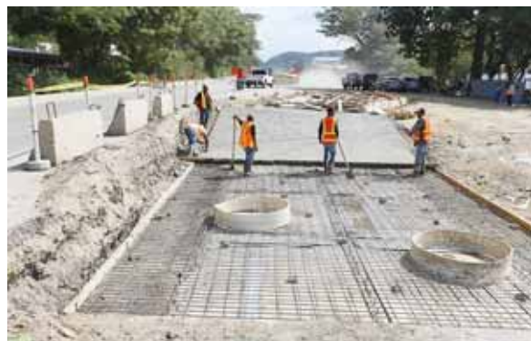
El primer tramo comprende 1,300 metros lineales de canal, desde el bulevar Las Torres hasta el plantel de Corinsa.
