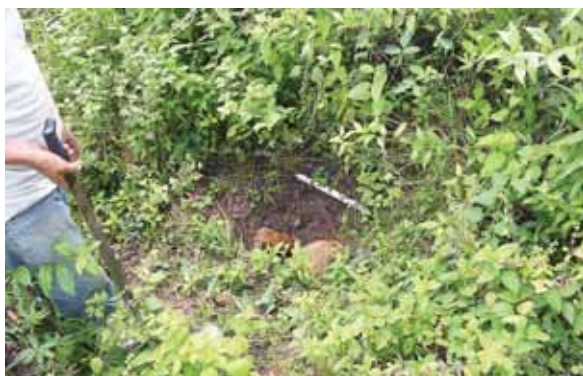
En ese agujero hay filtración de agua y según los afectados eso ha provocado que la tierra se afloje y cause los deslizamientos.
