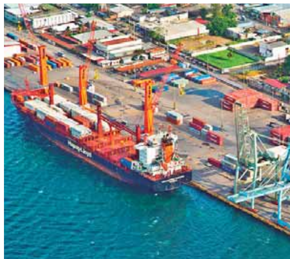
Vista panorámica que evidencia la modernización de Puerto Cortés.
