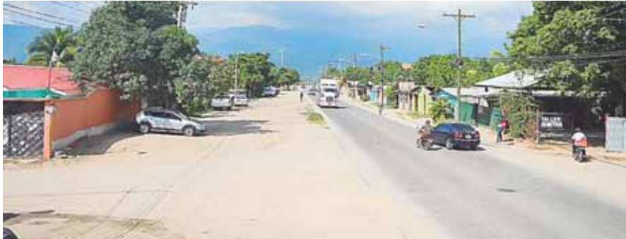
El proyecto también incluye obras complementarias, como la reubicación de postes y mejoramiento de sistemas de aguas negras.
