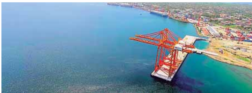
El muelle 6 es una ampliación de 350 metros adicionales a los 800 ya existentes. Cuenta con grúas Súper “Post-Panamax” que pueden cargar y descargar buques de gran tamaño.
