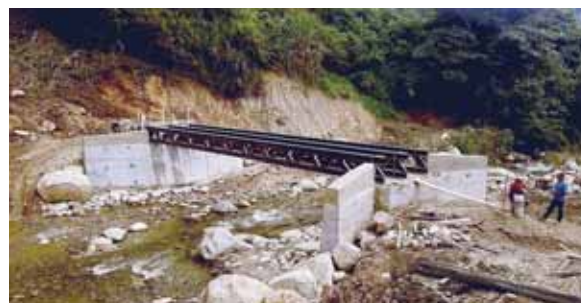
La obra tiene la longitud de 18 metros lineales, un ancho de cinco metros, un altura de 6.50 metros.
