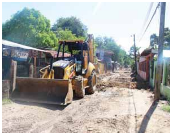
Son 290 metros lineales de pavimentación. La calle conecta con la CA-5 por lo que se espera sea usada como vía alterna.
