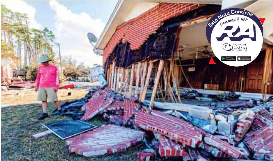
El pastor Geoffrey Lentz pasó por su casa dañada junto a la Iglesia Metodista First United, después de que destruida por la marejada ciclónica del huracán Michael. AFP
