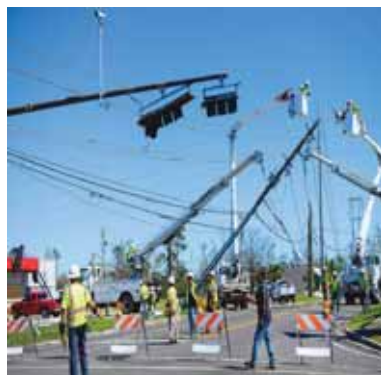
Trabajadores de servicios públicos reparan líneas eléctricas después del huracán.
