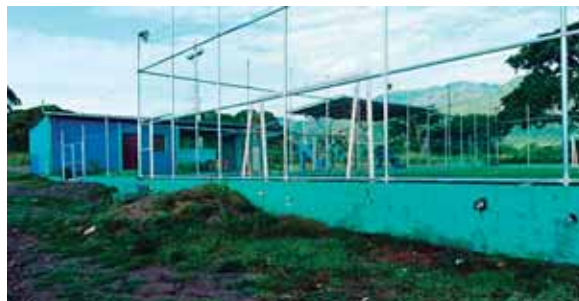
Este terreno es donde se construyó una cancha de fútbol, es también propiedad de José Elías Bustillo Carías, uno de los detenidos.
