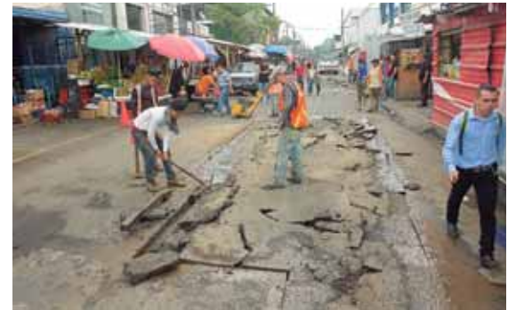
Ayer los equipos municipales trabajaron en la parada de buses, “Maheco”, y hoy avanzarán a la 3 y 5 calles.
