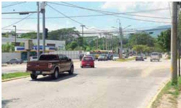
El proyecto inicia cerca del Colegio de Ingenieros, frente al Hospital Mario Rivas, para finalizar con obras de descarga en el río Piedras.
