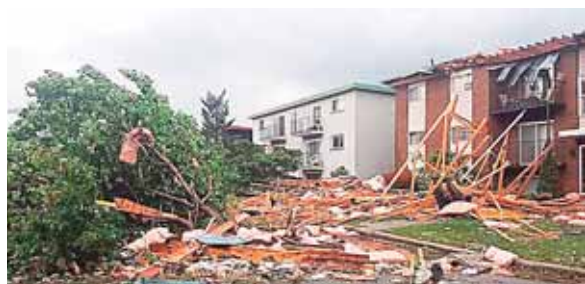
El fenómeno derribó líneas eléctricas a lo largo de la región que podrían llevar varios días en restablecerse y dar servicio.
