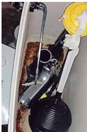
Hasta en los tanques de los baños se encontró armas.
