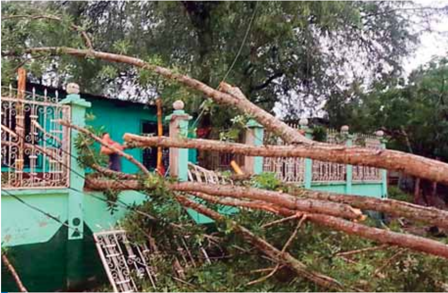
En el barrio Suyapa, de Pimienta, Cortés, se cayeron varios árboles, los cuales causaron daños a algunos inmuebles.
