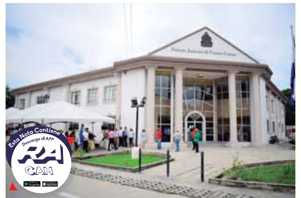
La remodelación incluyó el cambio del techo, puertas y ventanas, además del acondicionamiento de oficinas, entre otras mejoras.
