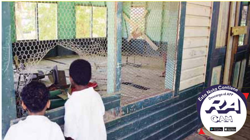
Las autoridades educativas han tenido que cerrar varias aulas porque la madera ha colapsado.
