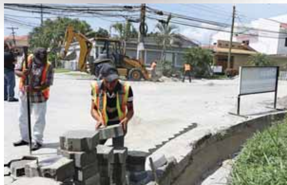
Los equipos municipales están trabajando en unos 1,200 metros lineales de calles y avenidas en la colonia Los Castaños.
