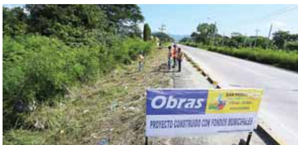
La obra tiene una longitud de 200 metros lineales con un área de pavimento de concreto hidráulico de 550 metros cuadrados.
