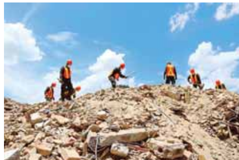
Después de una semana de haber comenzado, los trabajos de demolición avanzan sin contratiempos.
