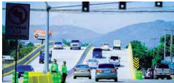
La parte de Infraestructura de San Pedro Sula se seguirá fortaleciendo y apunta a ser cada día más moderna con las nuevas construcciones.
