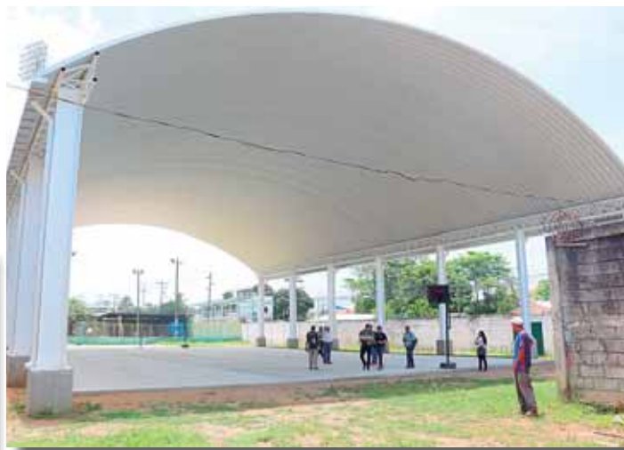
Techado de cancha multiusos.
