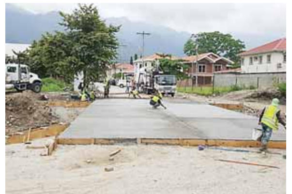
Este proyecto beneficiará directamente a unos 5,000 mil vecinos al evitar que las calles se inunden.
