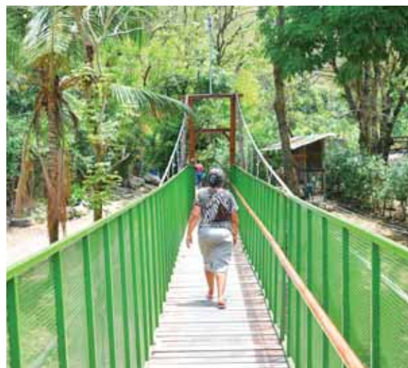
Este puente da acceso a la comunidad. Fue construido por los habitantes hace 19 años, pero la municipalidad le da mantenimiento.
