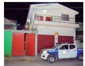
En esta casa de dos plantas operaba el centro de masajes.
