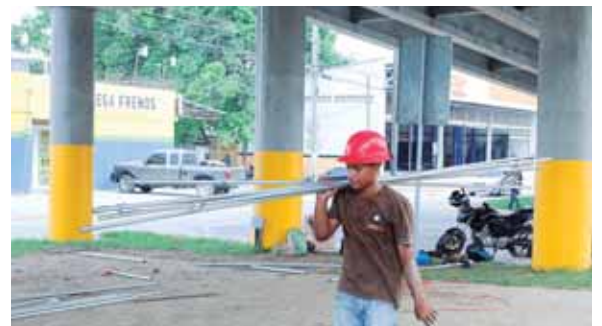
En total se instalarán 40 luminarias tipo LED de carretera, tanto en la parte superior de la estructura, como debajo de ésta.
