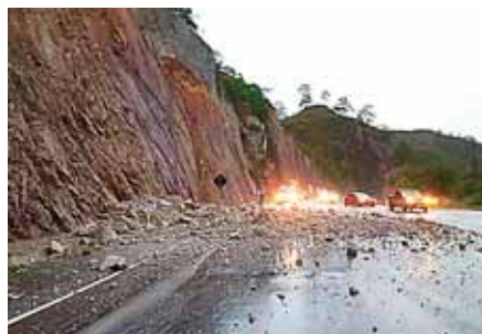
En el tramo conocido como Cuesta de la Virgen, en Comayagua, hubo derrumbes.
