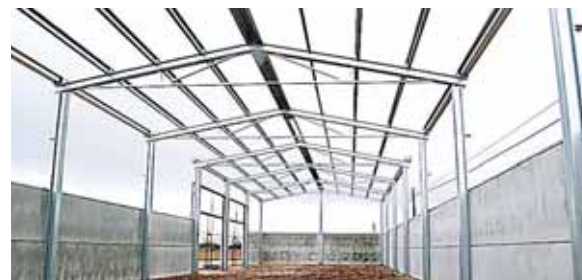
Naves ganaderas de estructura galvanizada.
