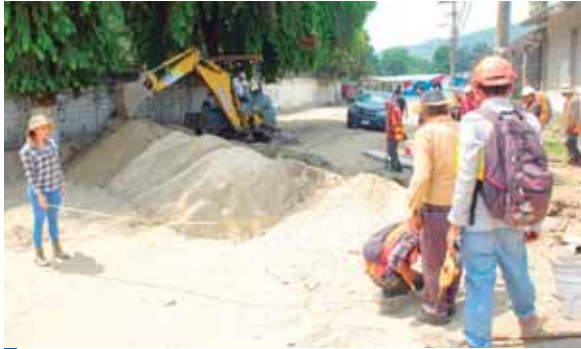
Estas obras son necesarias para poder pavimentar las calles de los barrios y colonias. Los obreros realizan trabajo de excavación.
