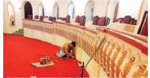
Colaborador trabaja en la remodelación del Teatro Manuel Bonilla.
