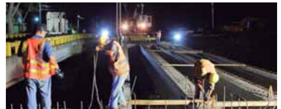
Las cuadrillas ahora trabajarán sobre la estructura del puente, fundición de losas de concreto hidráulico y la carpeta de rodeo.
