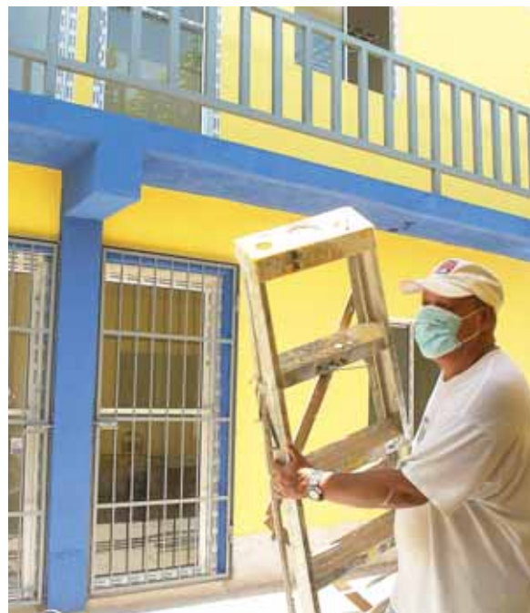
Un obrero con una escalera para continuar en las labores de remodelación de la estación policial en la Valle de Sula.
