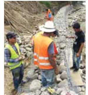
Colaboradores en la obra que está avanzada en un 80%.
