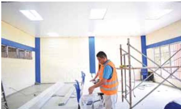
El proyecto incluye reparación de techos y el sistema de energía eléctrica en todas las aulas de las instituciones.
