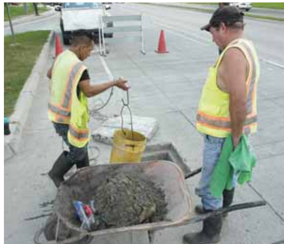
En los próximos meses se tiene prevista la construcción de otros dos colectores: uno en Calpules y otro en El Polvorín.
