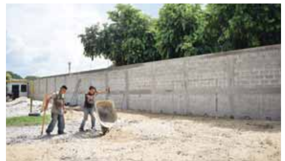
Las autoridades municipales reconstruyeron todo el muro perimetral que se derrumbó a causa de las fuertes tormentas.
