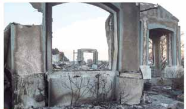
Algunas de las casas completamente destruidas en Santa Rosa, California. La gente debió abandonar todo.
