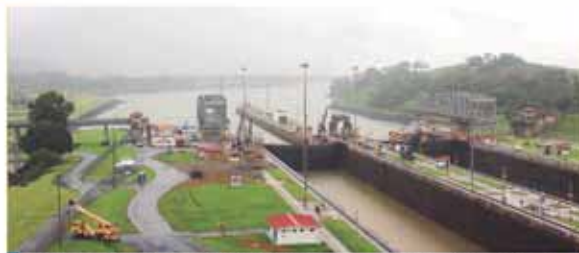
Panamá tiene un clima tropical, prácticamente no existe una estación seca.
