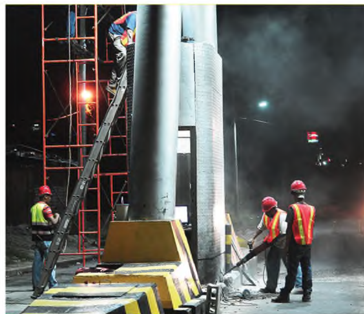
La instalación de los equipos se desarrollará de forma simultánea y en horas de la noche, para no entorpecer el tráfico.
